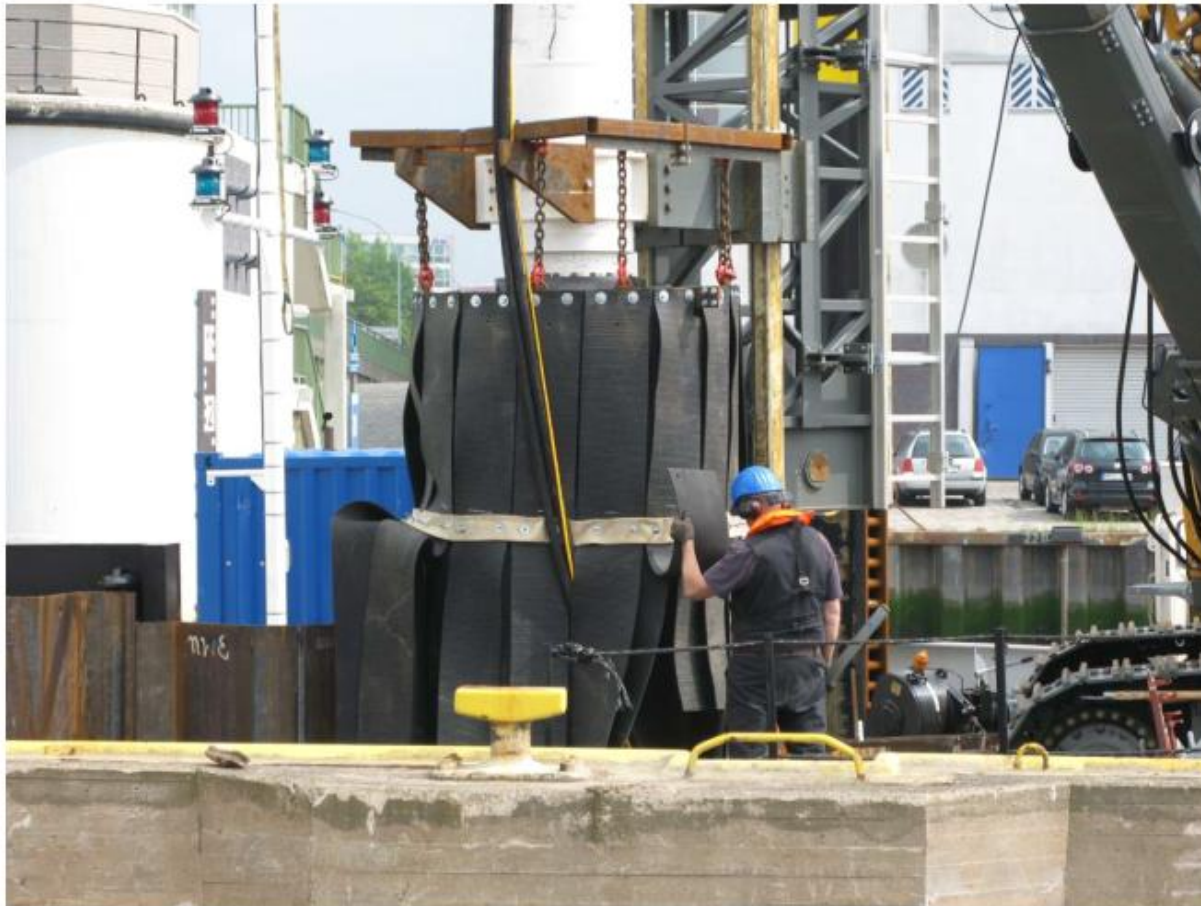
Abbildung 4: Einsatz einer Gummischürze an einer Ramme (Photo: WSA Bremerhaven)
