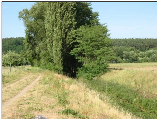
Abbildung 3: Vorflutgraben im Bereich des Obstbauggebietes, linkes Ufer
