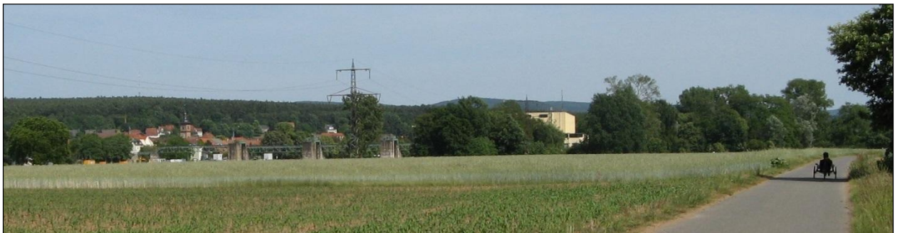
Abbildung 8: Blick vom linksmainischen Rad- und Wanderweg auf den Kirchturm von Obernau und die Bauwerke der bestehenden Staustufe
