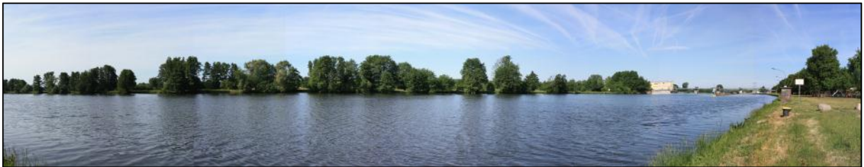
Abbildung 2: Panoramablick vom rechten Mainufer im Oberwasser auf die Staustufe
